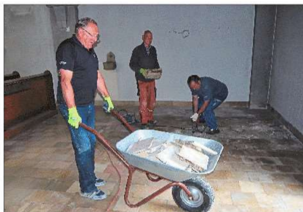
Steinberg packt gemeinsam bei der Sanierung des Gotteshauses an.
